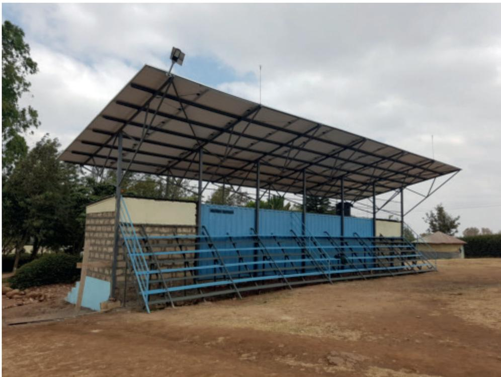
Photovoltaik-Anlage mit WC auf beiden Seiten und Stadionbestuhlung
